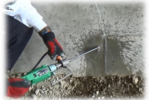
カートリッジ式注入材による施工
