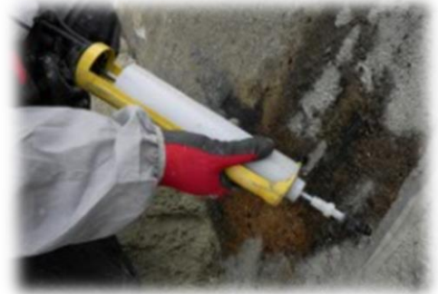
カートリッジ式注入材による施工
