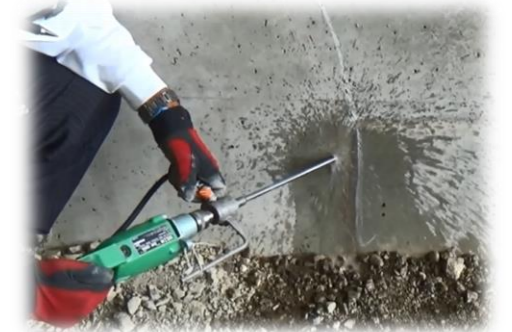
水流式ドリルによる注入口削孔
