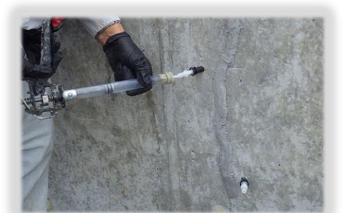
手動式注入ポンプでの加圧注入による施工
